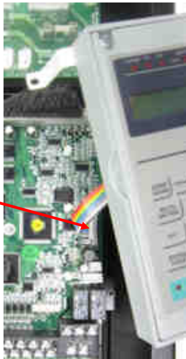
Рис. 7.25. Установка рамки пульта управления.
