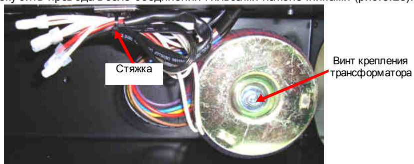
Рис. 6.26. Демонтаж трансформатора питания вентиляторов.
