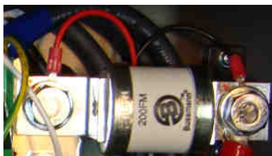
Рис. 6.7. Демонтаж силового предохранителя.
