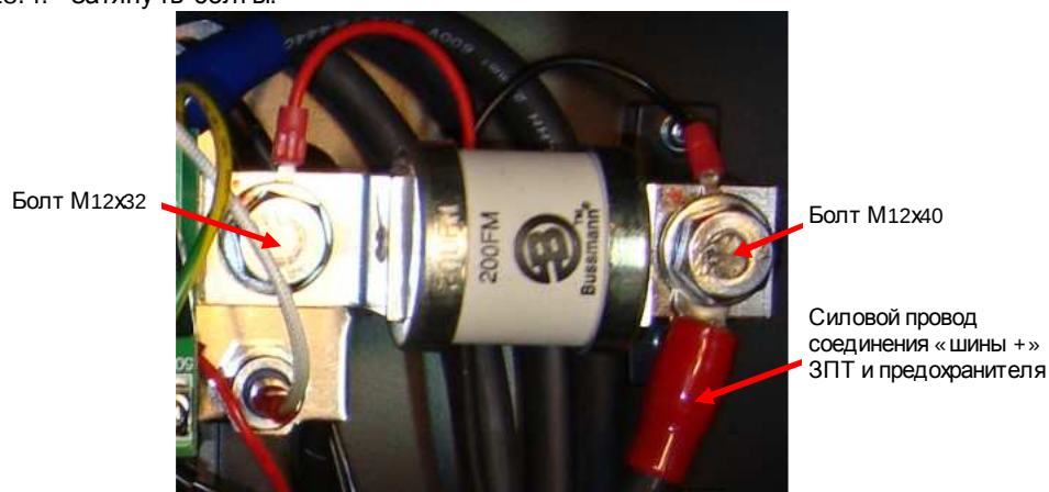
Рис. 7.20. Установка силового предохранителя.
