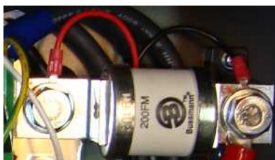
Рис. 6.7. Демонтаж силового предохранителя.
