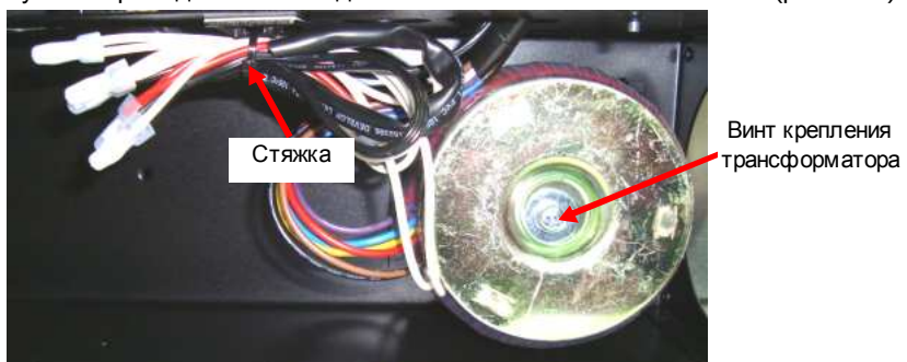
Рис. 6.26. Демонтаж трансформатора питания вентиляторов.
