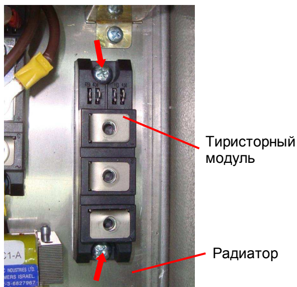
Рис. 7.2. Установка тиристорного модуля.
