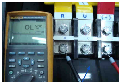
Щуп COM прибора к клемме R Щуп \Omega прибора к клемме (+)
