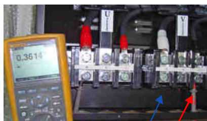
Щуп Ω прибора к клемме (-)
