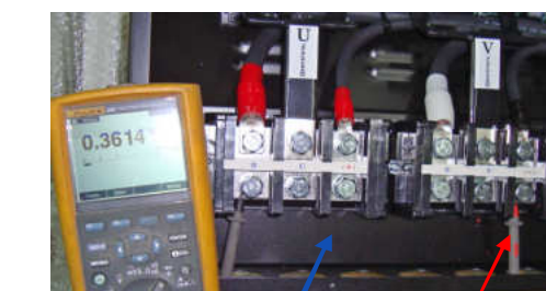
Щуп COM прибора к клемме R
