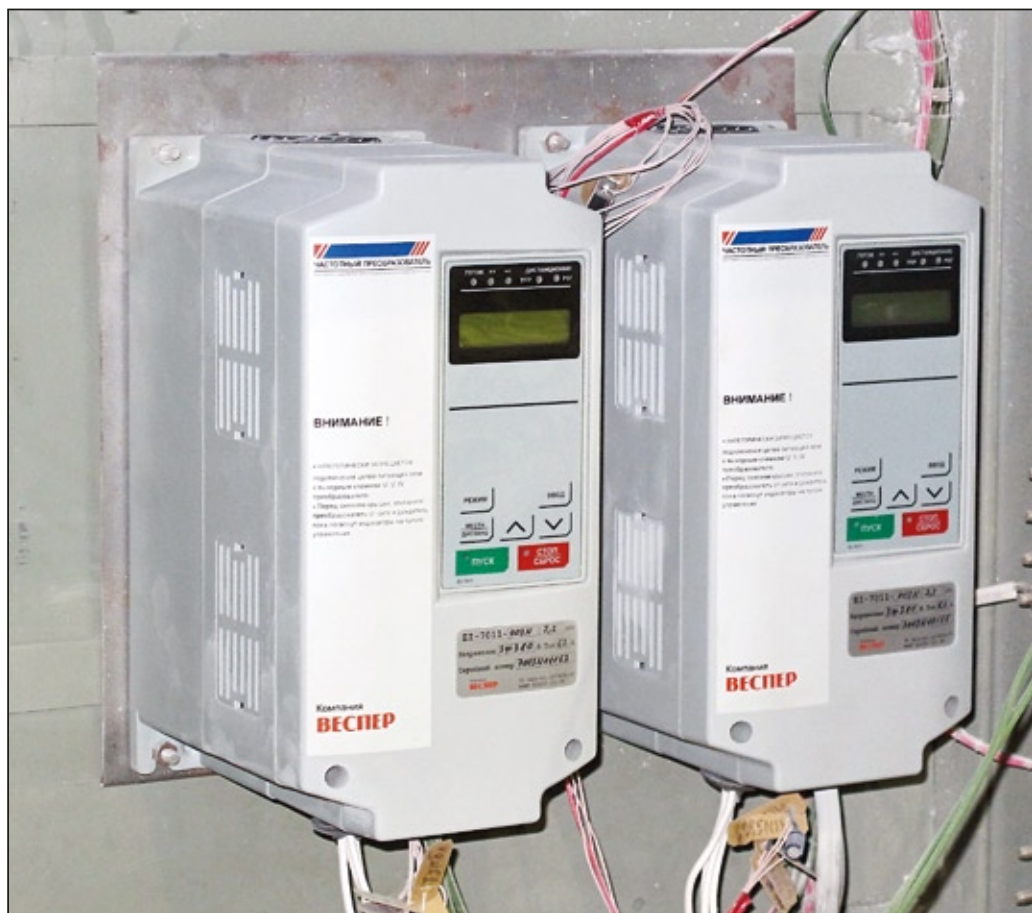
Преобразователи частоты EI-7011-003 дозаторов вяжущего вещества
