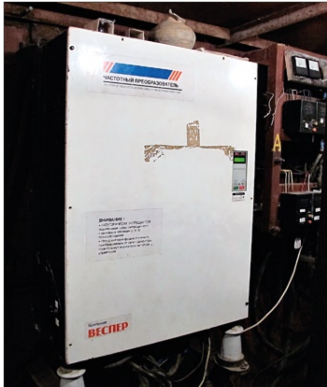
ЕI-P7002-175H (фото слева) управляет насосом подачи раствора (фото в центре). Буровая установка на объекте (фото справа)
