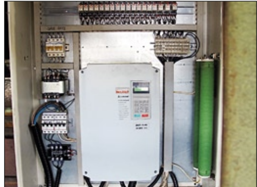
EI-9011-020H привода тележки мостового крана
