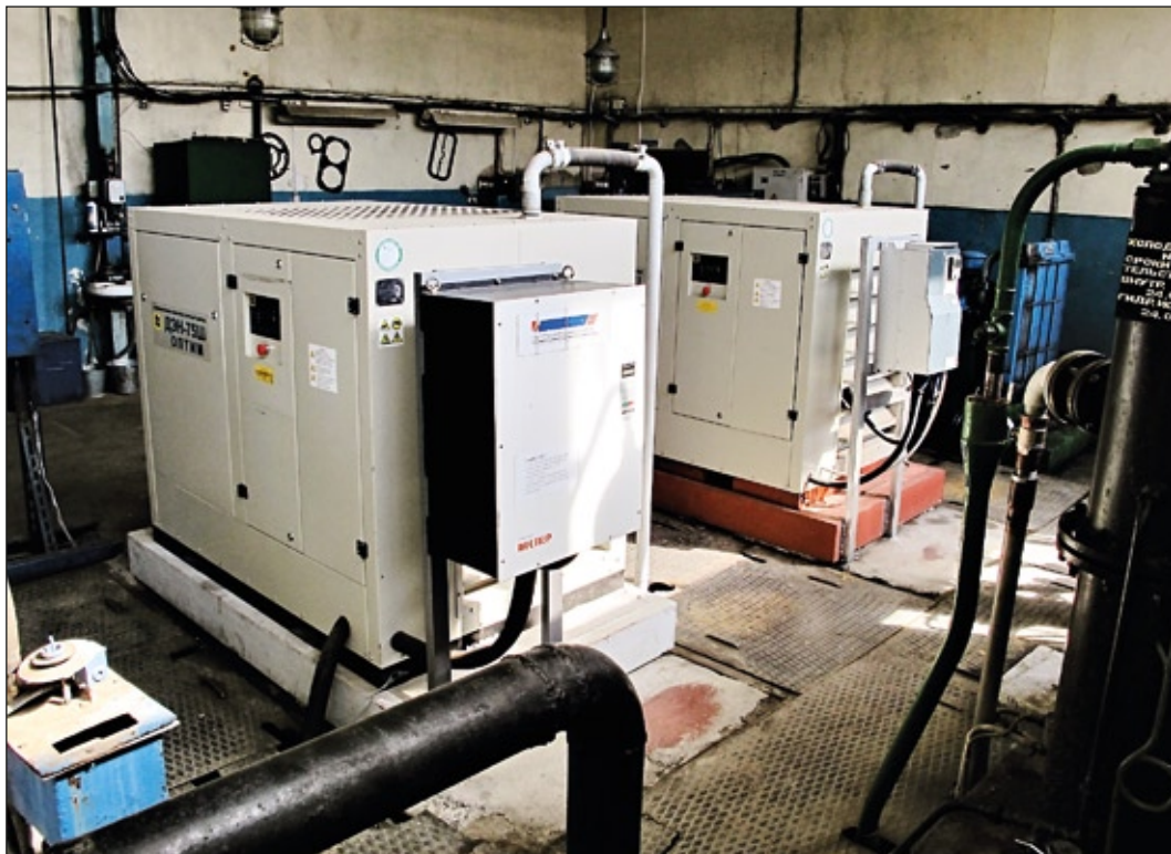
ЕI-9011 привода компрессора ДЭН-75Ш
