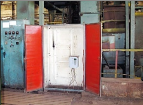
Один маленький Веспер заменил целый шкаф управления привода рольгангов
