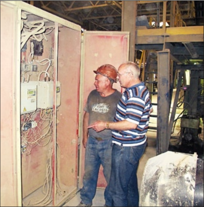
Фото слева: Плавный пуск привода грубого помола обеспечивает ДМС мощностью 160 кВт. Фото в центре: Привод вентилятора сушильного барабана. Фото справа: Устройства плавного пуска вальцов тонкого помола.
