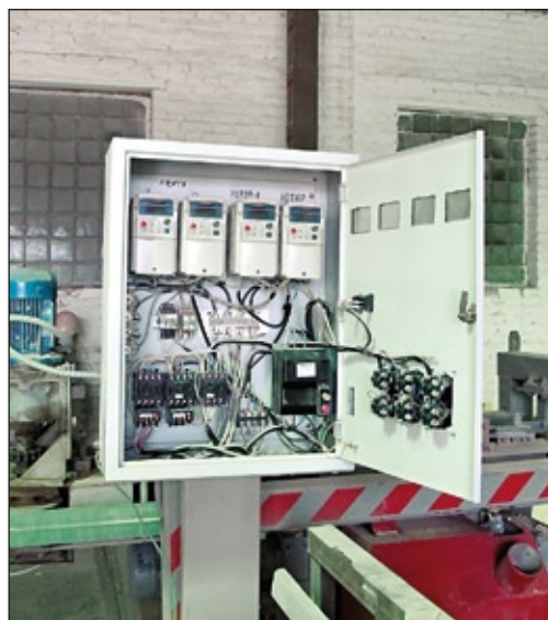
EI-8300 строго выдерживают технологию изготовления декоративного кирпича (фото слева). EI-7011-100N привода дымососа с тормозным прерывателем (фото справа).
