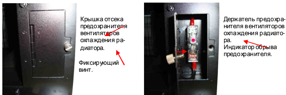
Рис. 4.26. Предохранитель цепи питания вентиляторов охлаждения радиатора
