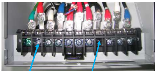
Клемма « R/L1 » Щуп « COM » прибора Клемма « N » Щуп « Ω » прибора
